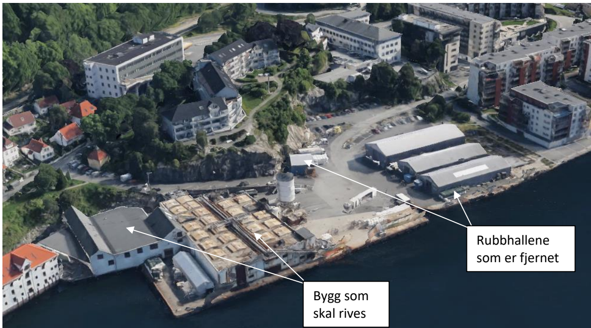
Figur 4. Bygninger som skal rives ifm. tilrettelegging av riggområdet er vist i kart og i 3D-oversikt (Google Earth). Rubbhallene (4 stk.) har vært demontert og flyttet.
